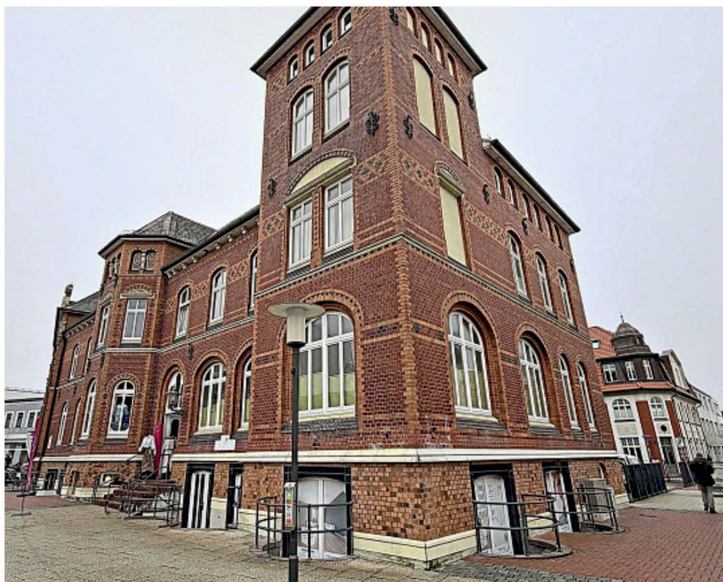
Wer wird der neue Eigentümer? Das Gebäude des früheren Norderneyer Postamts wurde in den Jahren 1891/2 errichtet.
